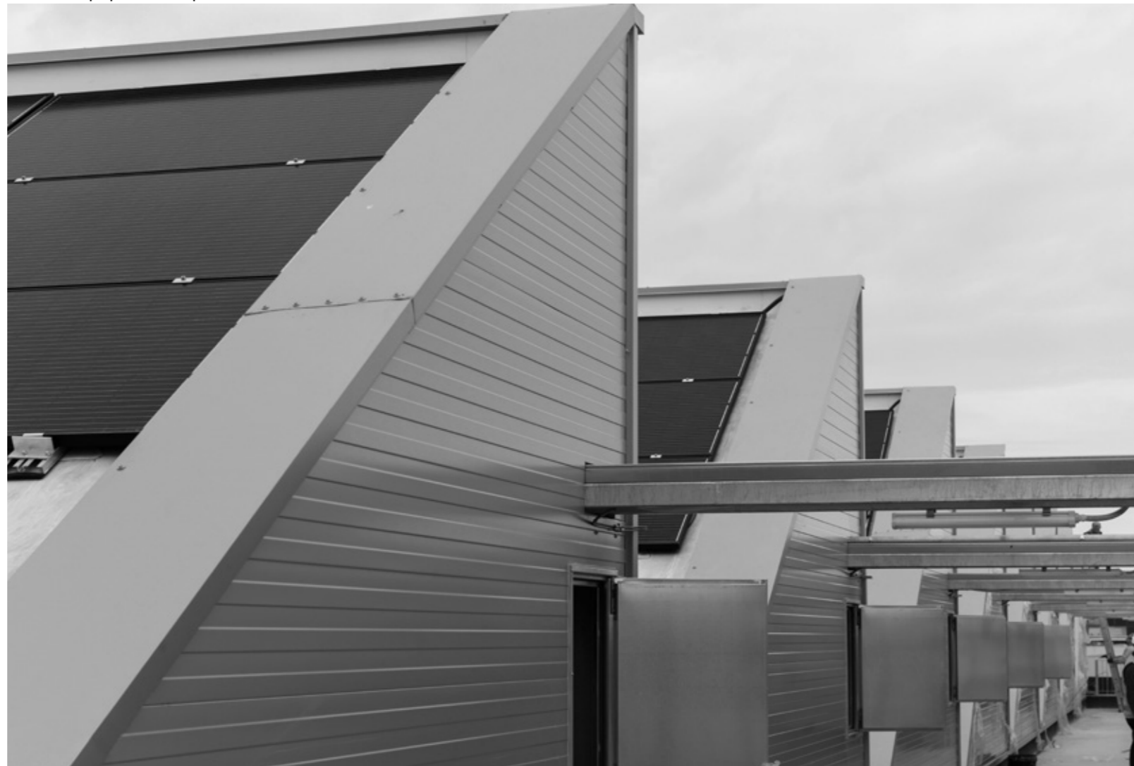
Instal·lació de plaques fotovoltaïques al mercat bio.
